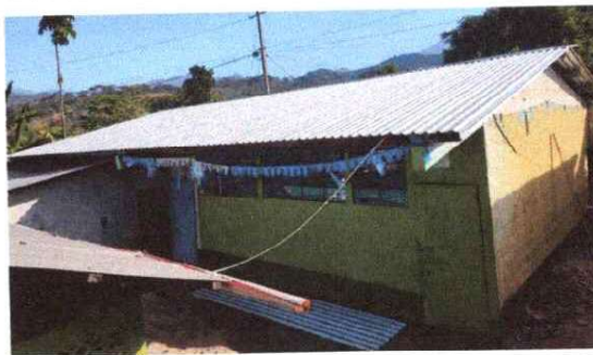
Foto 2: Sustitución de lámina, por lamina troquelada aluzinc calibre 26
