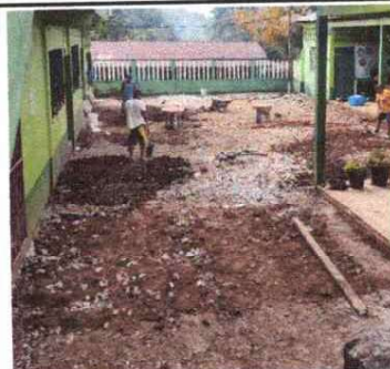
Foto 4: Sustitución de piso de torta de concreto.
