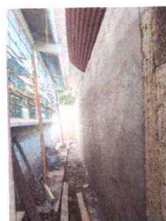
Foto 6: Repello en muro.
